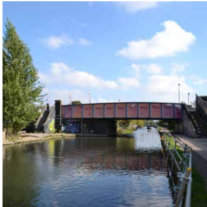
29. Mitre Bridge NW10 6QE
