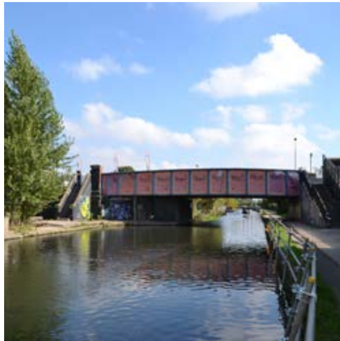
29.Mitre Bridge NW10 6QE
