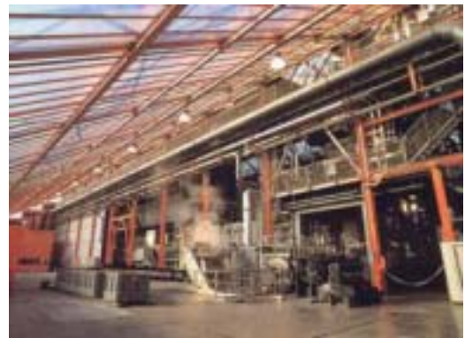
Process hall / Fondotoce
